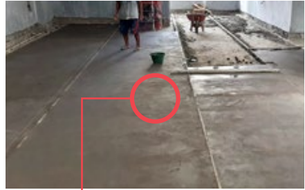
Aplikasi lantai kerja ( Floor screed )
