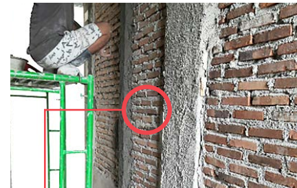
Proses perataan pada substrat
