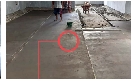
Aplikasi lantai kerja (Floor screed)
