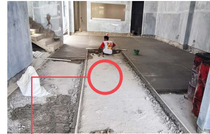
Proses perataan pada substrat
